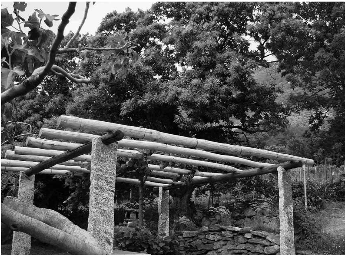
Claro, pergola con travi di legno di castagno, tipica costruzione rustica Ticinese.
